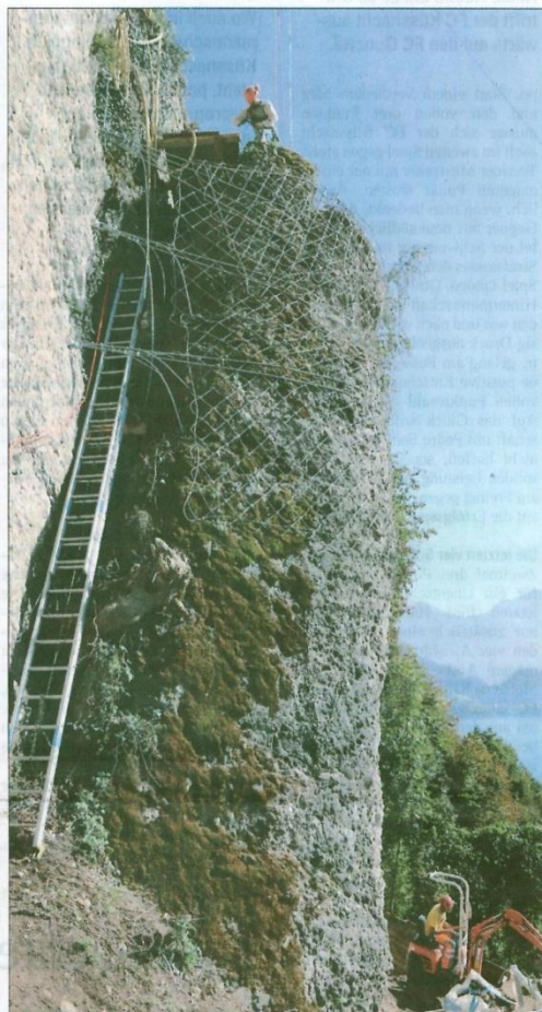
Die Arbeit im abschüssigen Gelände in der Horlauri verlangt von den Felstechnikern höchste Konzentration. Geologe Conradin Zahno (Mitte links) begleitet die Sofortmassnahmen und integriert neue Bohraufschlüsse zum Felsaufbau laufend in die Planung. Die Ausbildung offener Klüfte über grosse Flächen (unten links) hat selbst ihn überrascht. Besonders einsturzgefährdete Felsstürme wie H16 (rechts) werden teilweise abgetragen und mit Ankern permanent gesichert. Fotos: Fabian Duss
