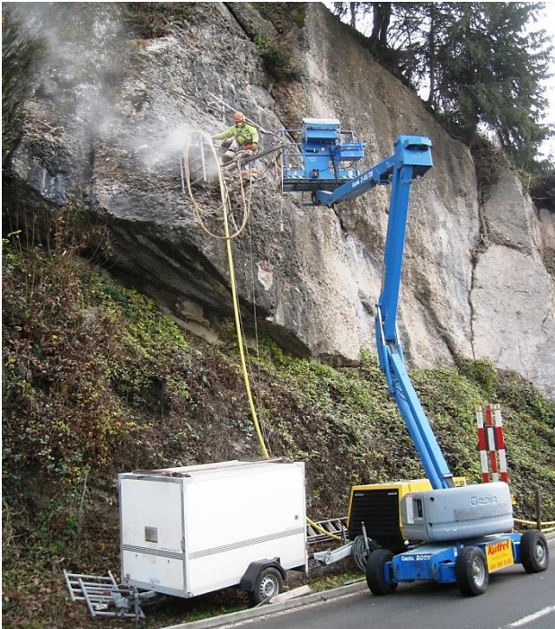
Destructive Sondierbohrung im Fels mit anschliessender Bohrlochkameraaufnahme (Foto vom 08.12.2014).
