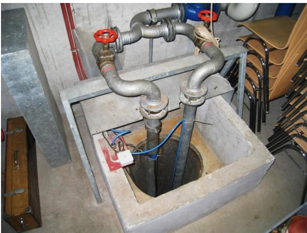
Beweissicherung/Monitoring Grundwasserwärme-Pumpe.
