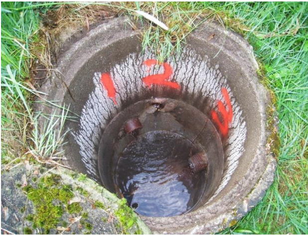
Beweissicherung/Monitoring private Quellwasserfassung.
