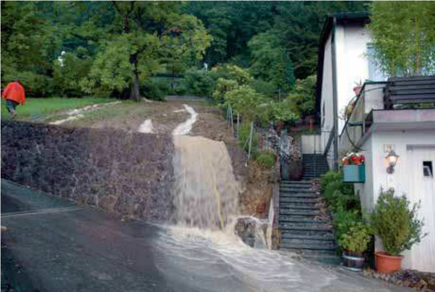
Abb. 2: Oberflächenwasserabfluss am 22. August 2005 im Gebiet Laugneri. Das Haus rechts wurde wenige Stunden nach dieser Aufnahme durch eine mehrere Tausend m 3 grosse Rutschmasse eingedrückt (Foto: K. Louis).
