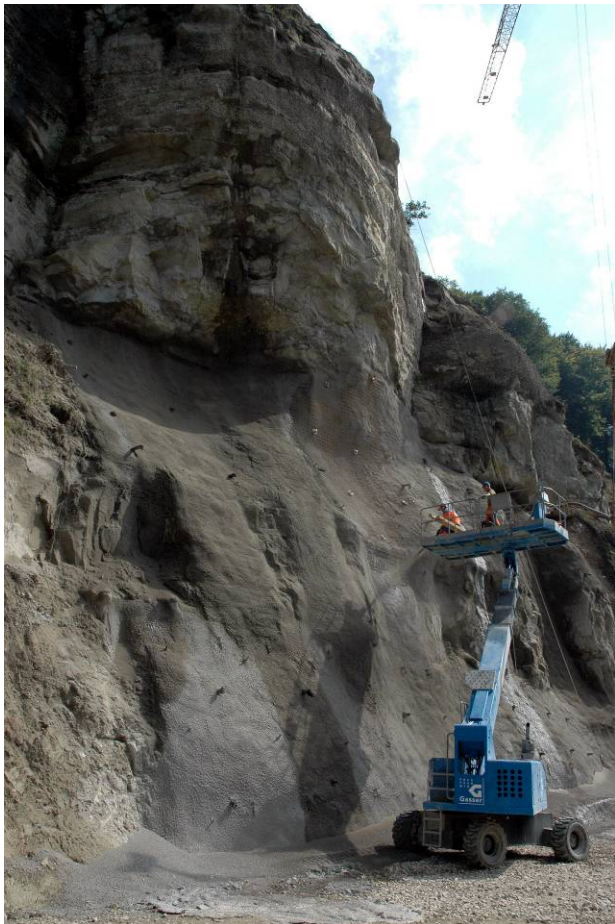
Bauzustand am 7. September 2007
