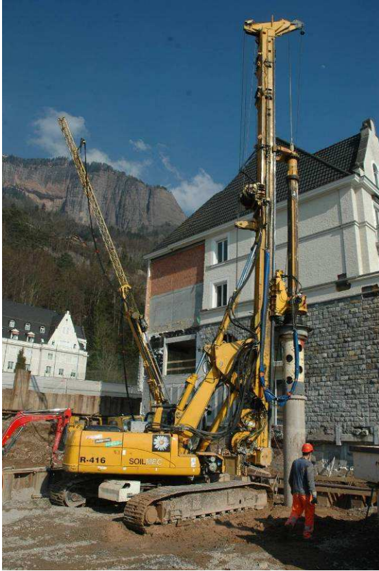
Das Bohrgerät beim Einsatz für die Erstellung der 12 m langen Bohrpfähle
