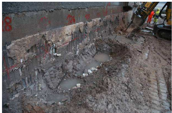
Freilegung und Kontrolle der Unterfangung
