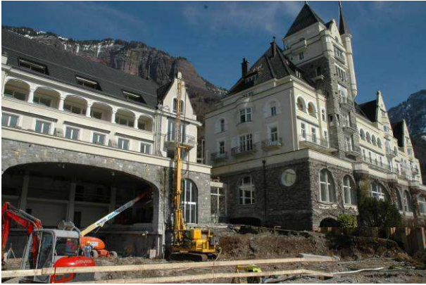
Die ehrwürdigen Gebäude vor dem Umbau.
