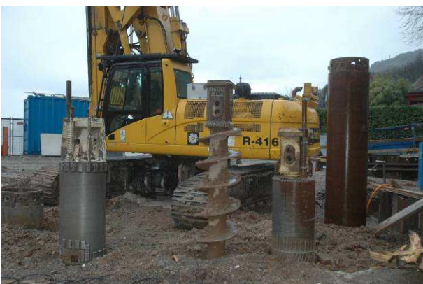
Die wichtigsten „Werkzeuge“ für die Erstellung der Bohrpfähle unterhalb des Grundwasserspiegels. Von links nach rechts: grosser Fangkorb, Bohrschnecke, kleiner Fangkorb, Verrohrung.
