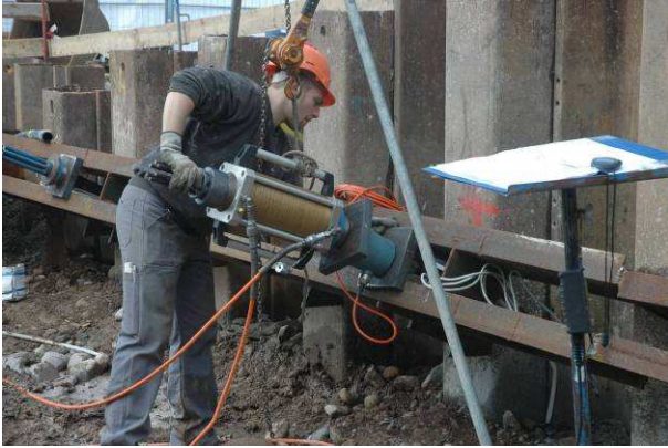
Vorspannen der Anker der Spundwandumschliessung
