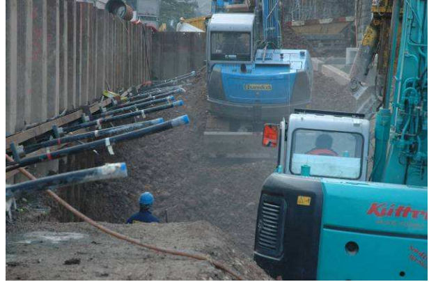
Nachdem die Anker vorgespannt sind kann die Baugrube ausgehoben werden.
