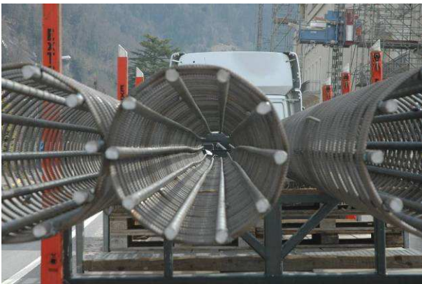
Anlieferung der Armierungskörbe für die Bohrpfähle
