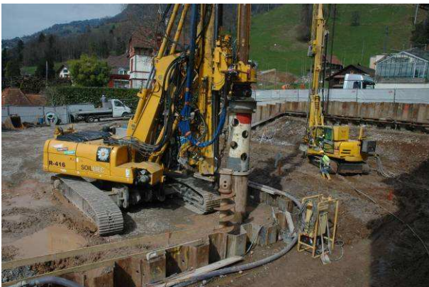
Bohrpfahl-Bohrgerät (links) und Jettinggerät (rechts)
