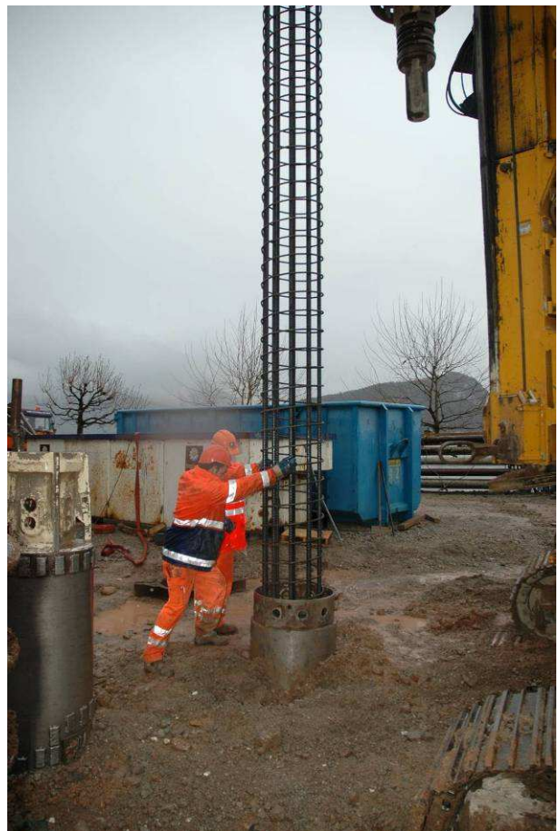
Einsetzen eines Armierungskorbes in das Bohrloch
