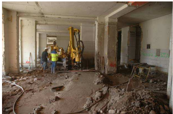
Unterfangung mittels Jettingsäulen im Gebäudeinneren
