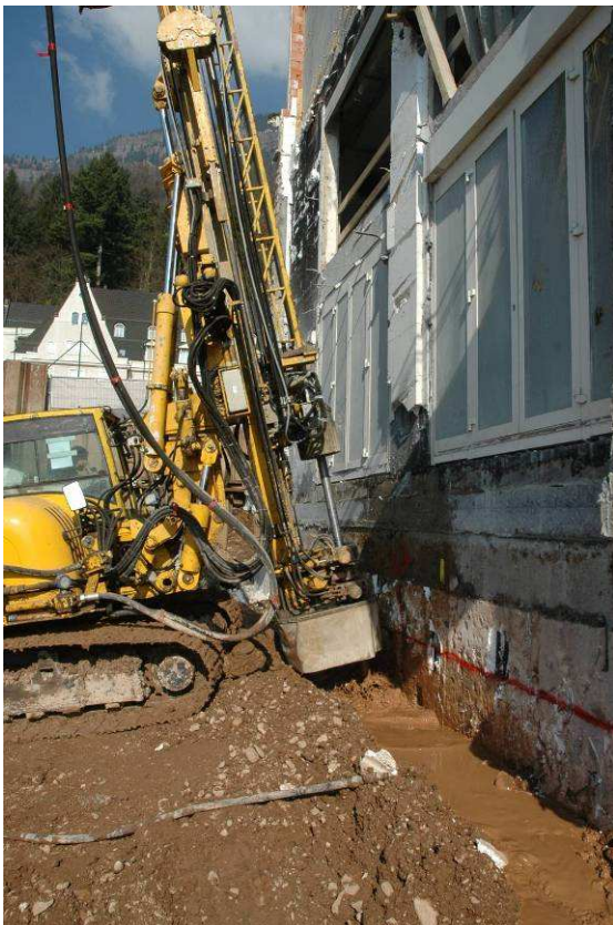
Unterfangung der bestehenden Grundmauern mittels 10 m langer Jettingsäulen
