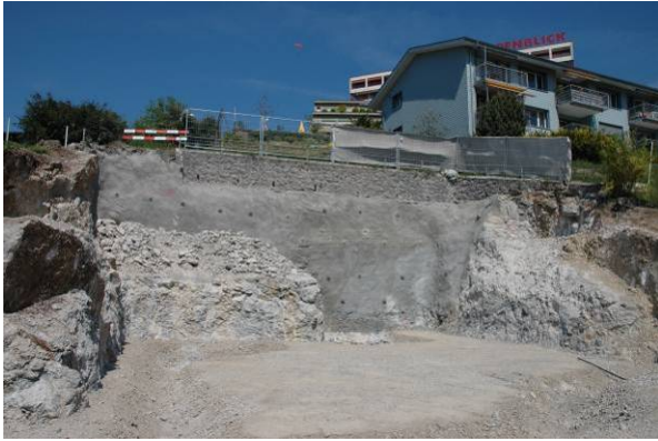
Baugrube Parkstrasse, kurz nach Abschluss der Böschungssicherungsmaßnahmen
