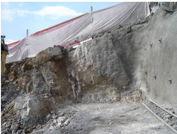
Baugrube Parkstrasse – Blick auf eine steile Störungsfläche in der hangauswärts einfallenden Nagelfluhabfolge
