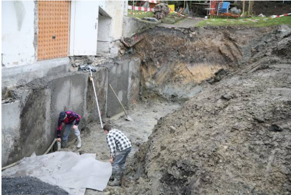
Baugrube Hofmattstrasse. Unterfangung des Nachbargebäudes
