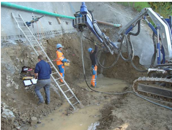
Baugrube Seewasserpumpwerk – Baugrubensicherung mittels Böschungvernagelung
