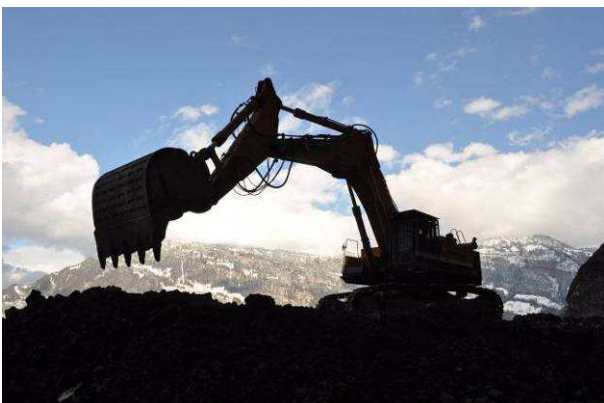
Der Raupenbagger im Einsatz vor dem Rigi-Panorama.
