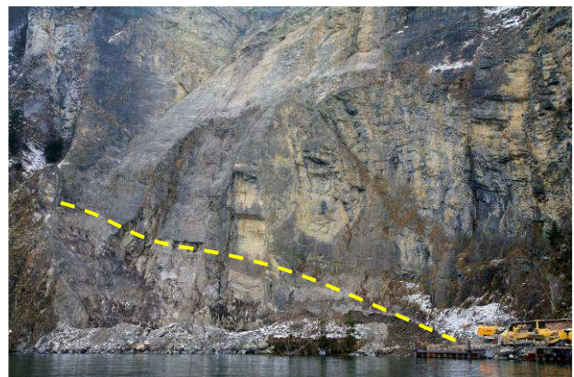
Die Steinbruchsohle kurz Abschluss der Räumungsarbeiten. Die gelb gestrichelte Linie zeigt die ehemalige Schuttkegelhöhe.
