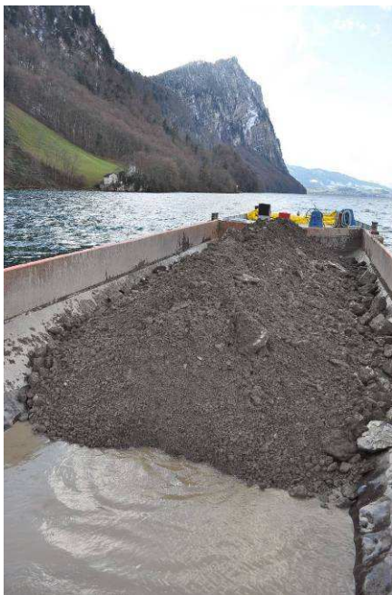
Das Sturzmaterial wird in den See verklappt.
