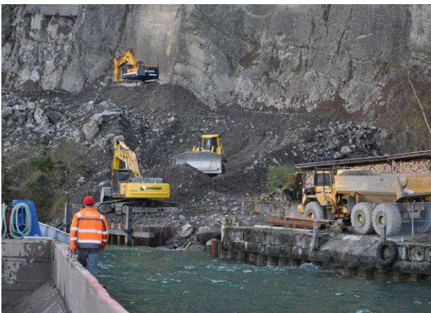
65'000 m 3 Sturzmaterial muss von der ehemaligen Steinbruchsohle abgetragen werden.
