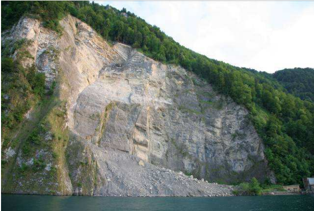
Der ehemalige Steinbruch Obermatt vor Beginn der Fallbodenräumung
