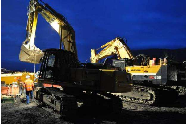
Die Räumungsarbeiten beginnen früh am Morgen.
