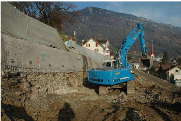
Baugrubensicherung
