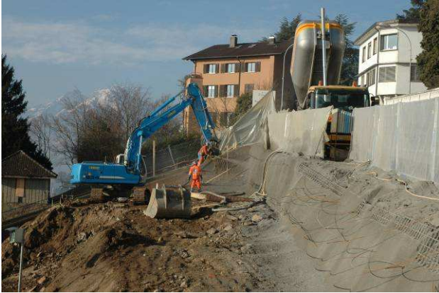
Gunitierung der Baugrubenböschung
