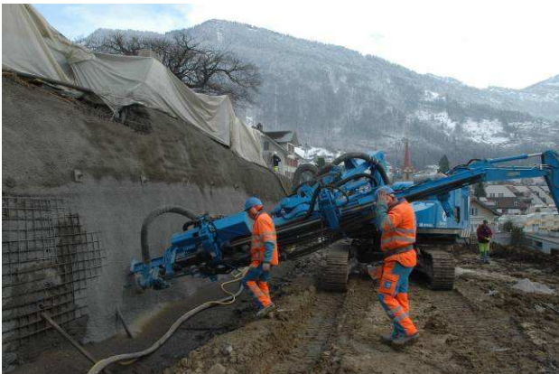
Bohren der Löcher für die Nägel
