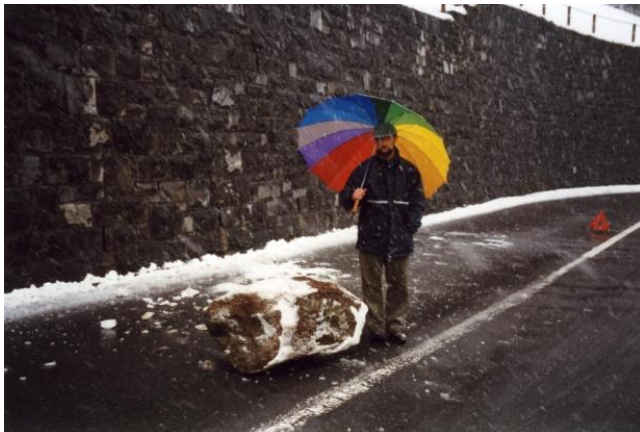
Steinschlag im Jahr 1999 auf die Strasse bei Platten, Mollis.
