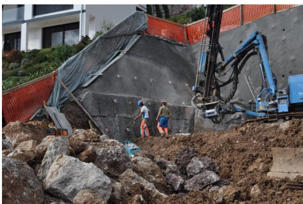
Im Hintergrund die abgesicherte Schwergewichtsmauer aus Sickerbeton; im Vordergrund Blöcke aus dem Aushub
