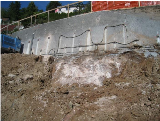
3. Aushubetappe mit gleichem Block wie im obigen Bild
