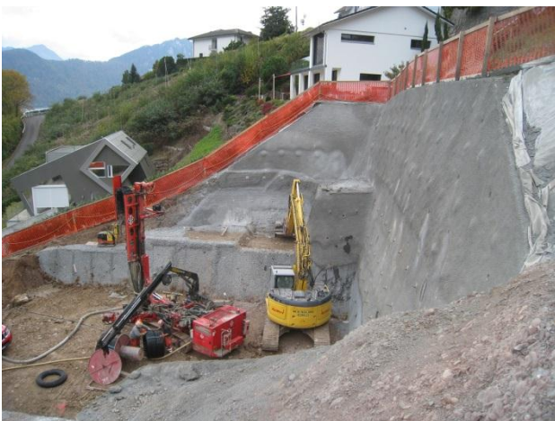
Ansicht der fertig gestellten Baugrubensicherung
