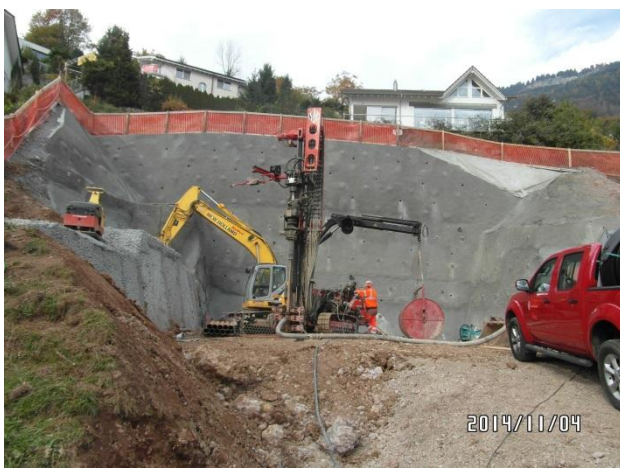
Ausgehobene und abgesicherte Baugrube zum Zeitpunkt der Erdsondenbohrungen
