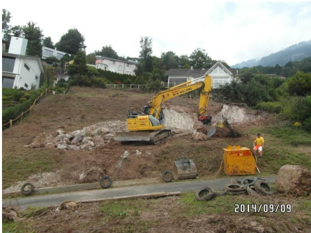
Parzelle Nr. 916 beim Beginn der Aushubarbeiten
