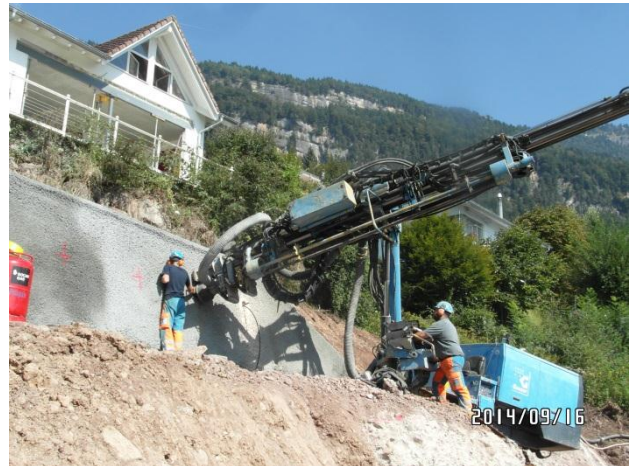
Bohrung für einen permanenten Anker
