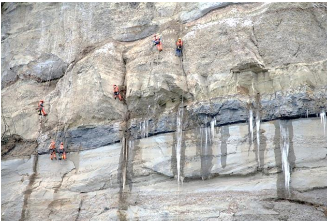
Felsreinigungsarbeiten
