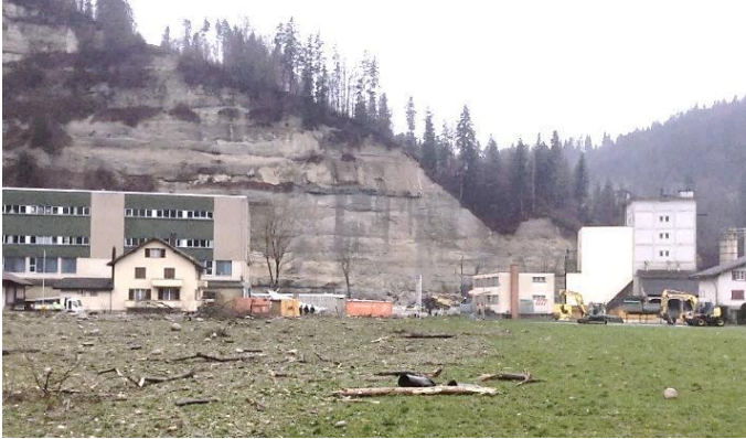
Aufnahme der Badflue vor Ausführung der Sofortmassnahmen.
