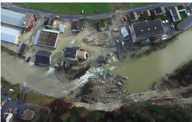
Drohnenaufnahme des Ausbruchs-, Ablagerungs- und Überflutungsbereiches (© ZSO Emmen).
