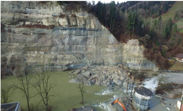
Drohnenaufnahme des Ausbruchs- und Ablagerungsbereiches des Felssturzes kurz nach dem Ereignis (© ZSO Emmen).
