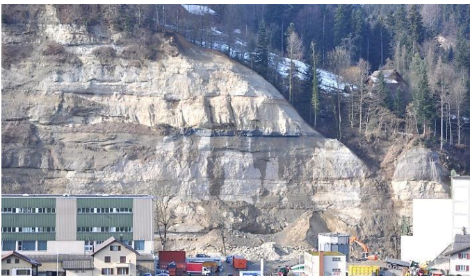
Aufnahme der Badflue nach Ausführung der Felsabtragsarbeiten.
