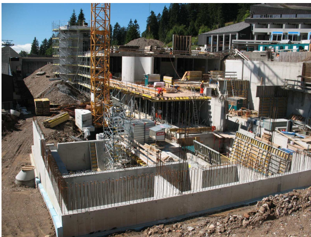
Stand der Arbeiten Anfang September 2011
