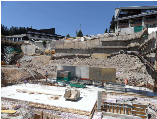
Die Baugrube für das neue Mineralbad, Ende Juni 2011
