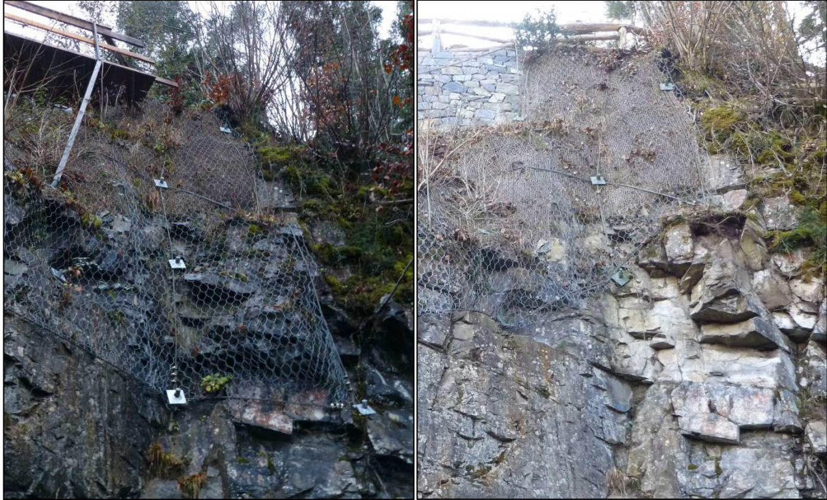
Abb. 18 und 19: Bestehende Felsabdeckung vor (links) und nach (rechts) der Nacharbeiten
