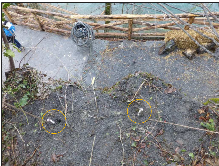
Abb. 13: Vertikal versetzte Felssicherungen im Massnahmenbereich MB 6
