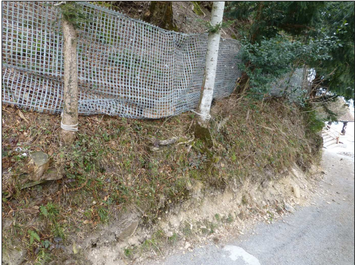
Abb. 2: Temporäre Steinschlagschutznetze
