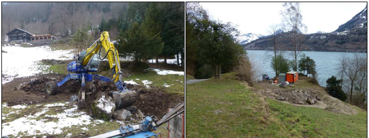
Abb. 6 und 7: Einbaubereich des Abtragsmaterials
