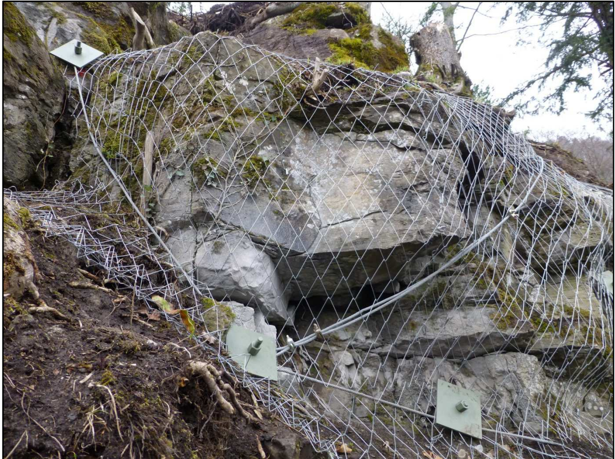
Abb. 17: Neu erstellte Felsabdeckung inkl. zusätzlichem Spannseil (MB 2 gemäss Abb. 1)
