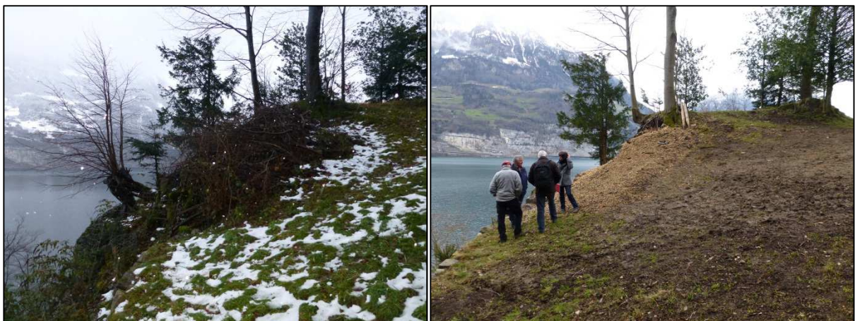
Abb. 8 und 9: Situation vor bzw. nach den Felsabträgen
