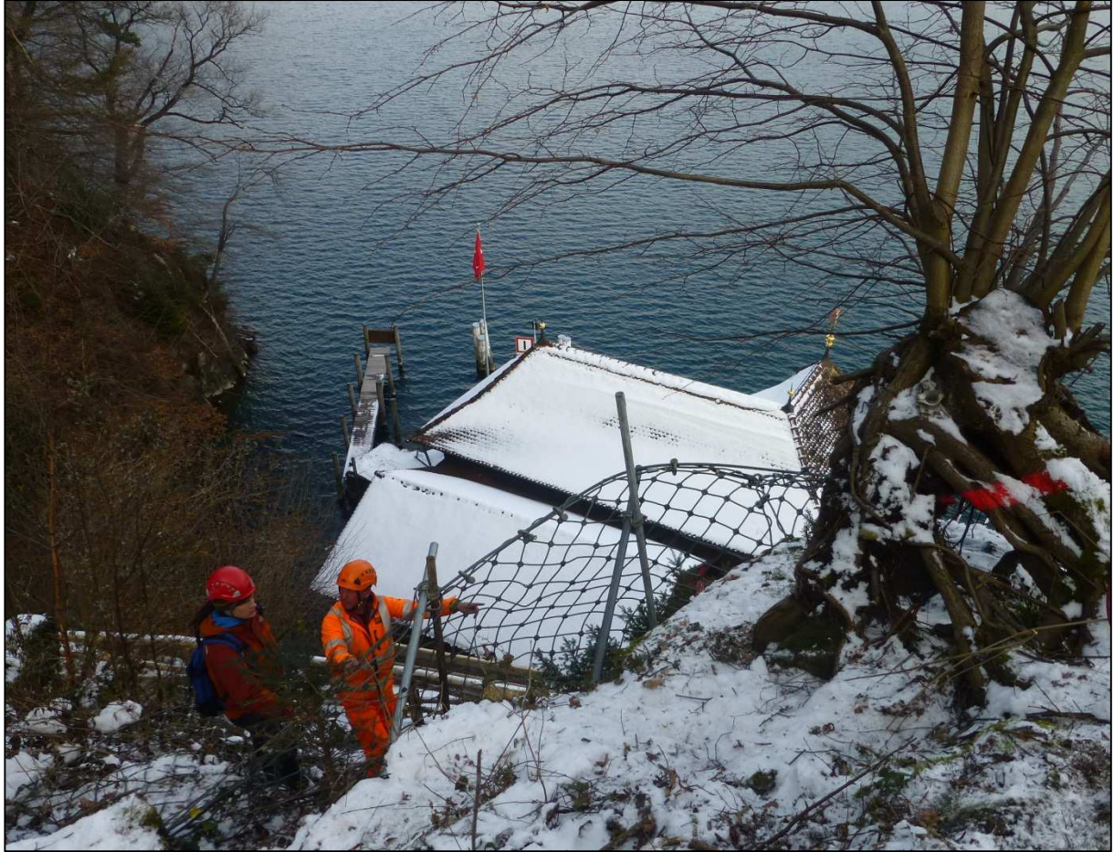
Abb. 3: Aufgespanntes Drahtseilnetz
