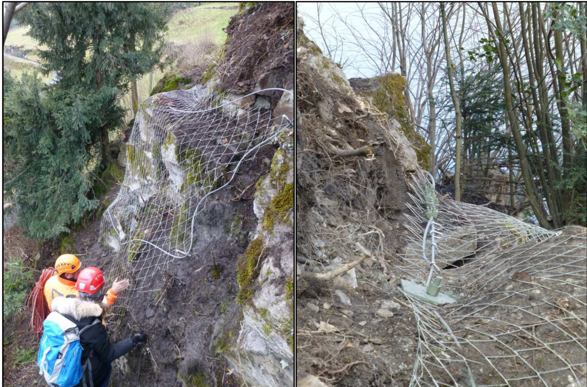
Abb. 15 und Abb. 16: Ansicht und Detail der Felsabdeckung im MB 1 (links: Bauzustand)
