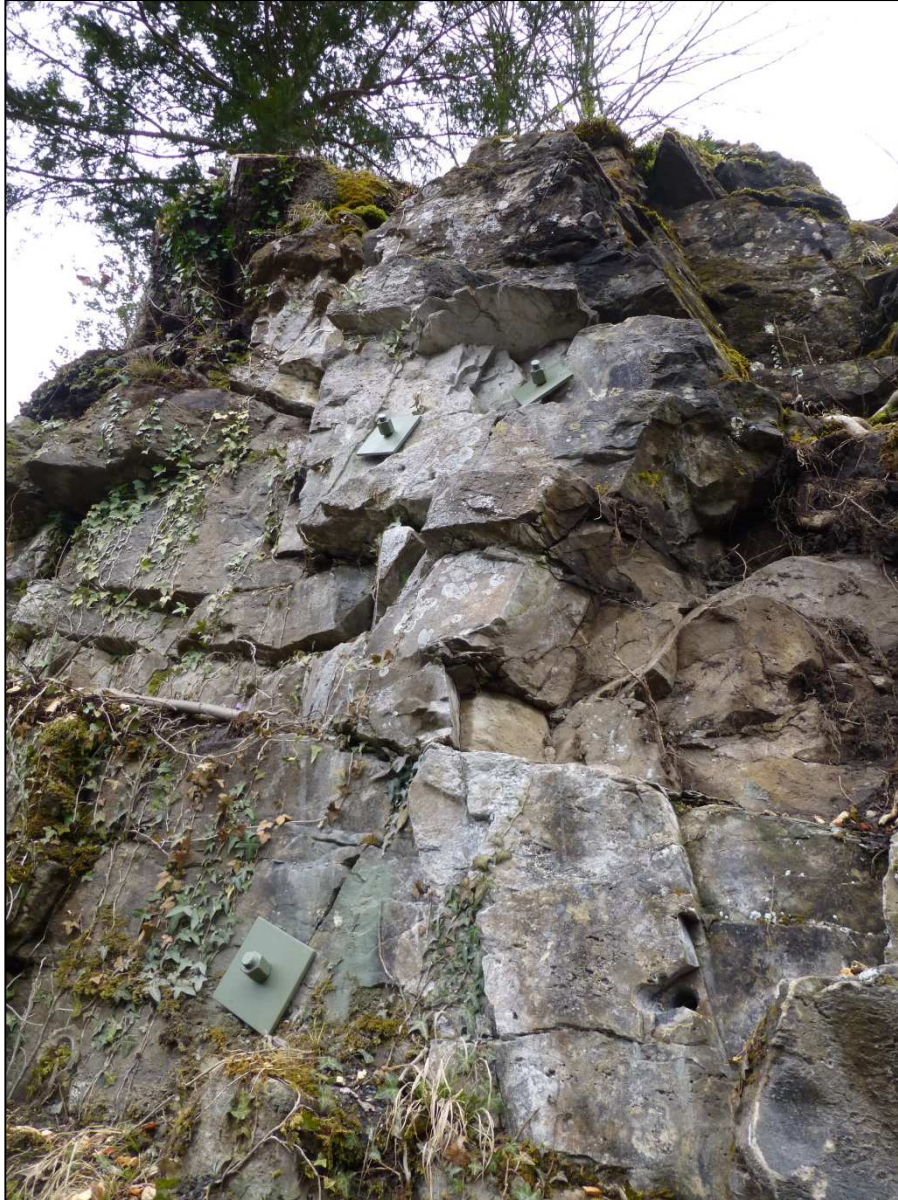
Abb. 14: Horizontal versetzte Felssicherungen im Massnahmenbereich MB 3
