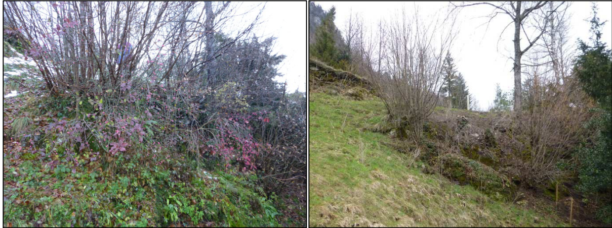
Abb. 10: und 11: Situation vor (links) und nach (rechts) Abtrag der Natursteinmauern
