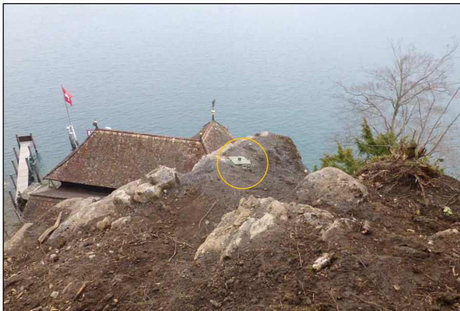
Abb. 12: Vertikal versetzte Felssicherung im Massnahmenbereich MB 4
