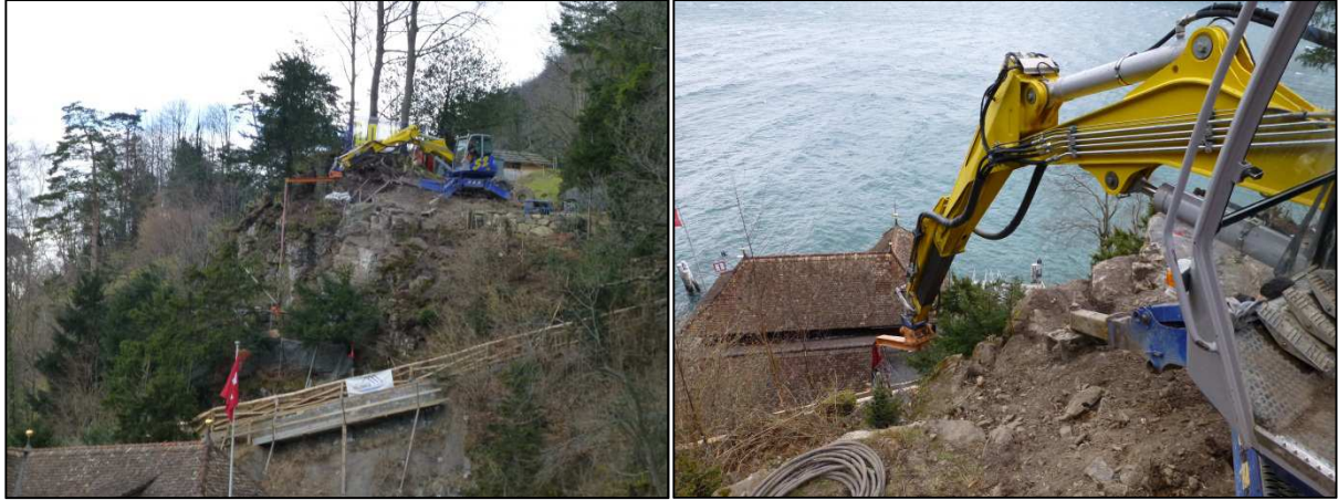
Abb. 4 und 5: Abtragsarbeiten im oberen Felswandbereich
